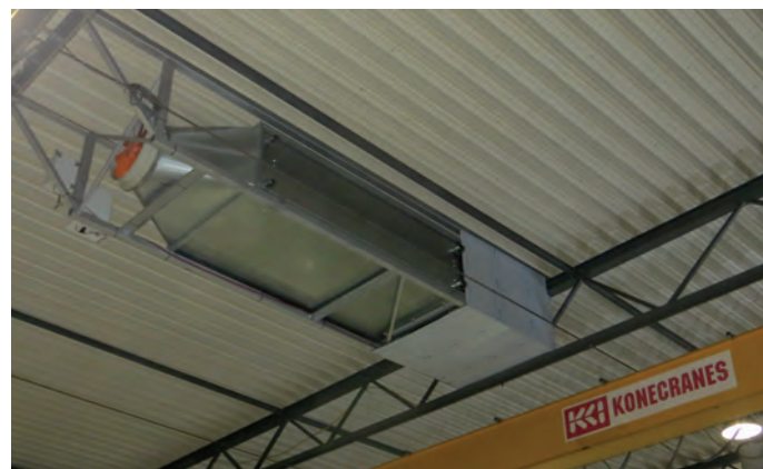
Afb. 3 Een Aufero-opstelling voor het reinigen van de interne lucht ter verbetering van het binnenklimaat
