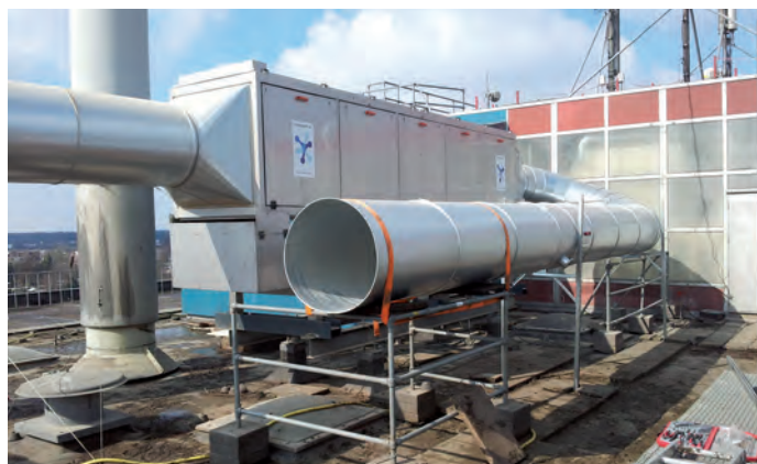
Afb. 2 De Aufero als end-of-pipe systeem waarmee de uitgaande lucht wordt gereinigd
